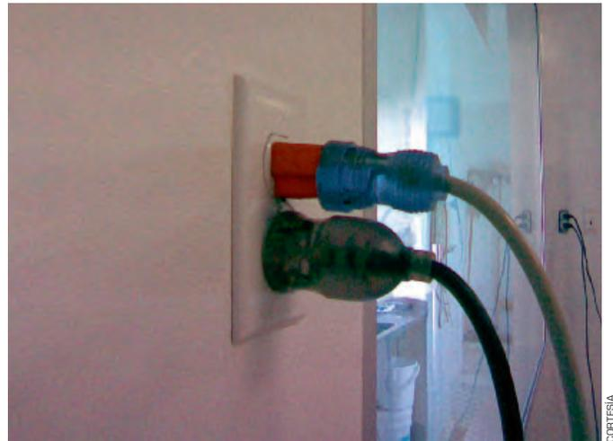
Imagen 1. Ejemplo en el cual los equipos tienen cable grado médico acorde con la reglamentación pero están conectados a una toma de pared incorrecta.
